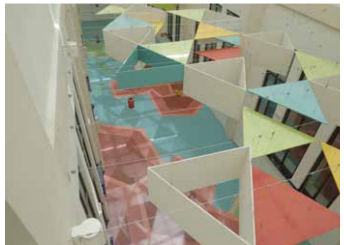
Pavimento decorativo con el sistema MasterTop 1325 colocado en el Polo Nacional de Contenidos Digitales de Málaga
